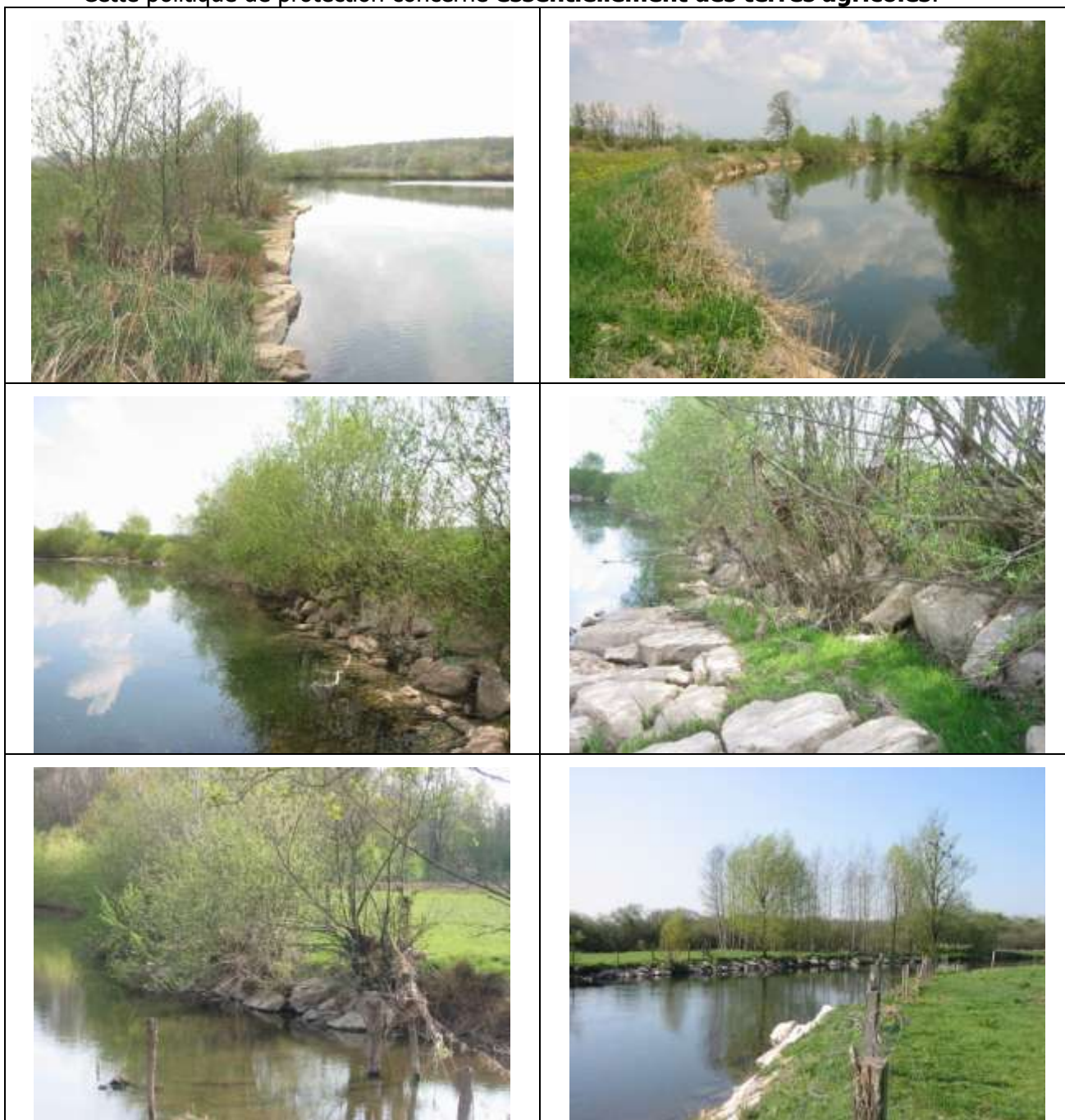
planche photo 10 : protections de berges sur l'Ognon.
