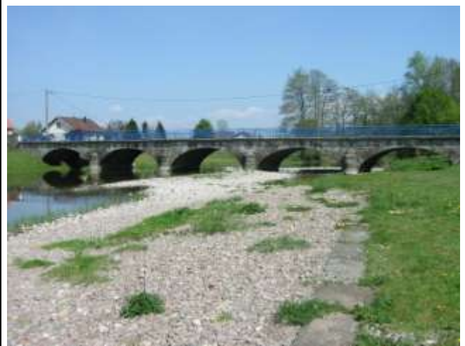
Secteur de Vouhenans : accumulation alluviale sous et en aval du pont
