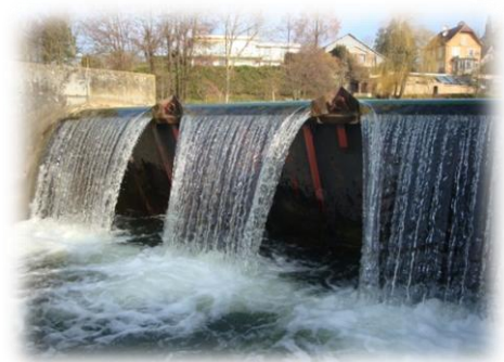
Vannage du barrage de Marnay (70)
