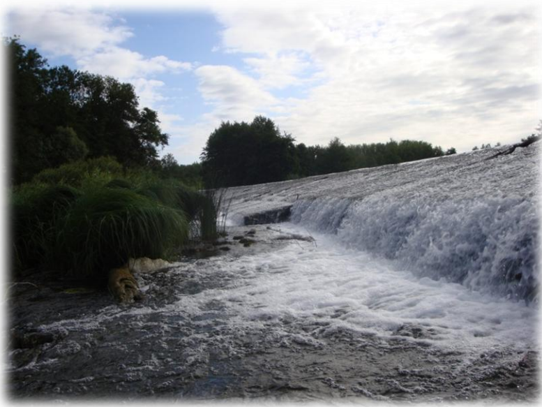
Le barrage des Forges à Pesmes (70)
