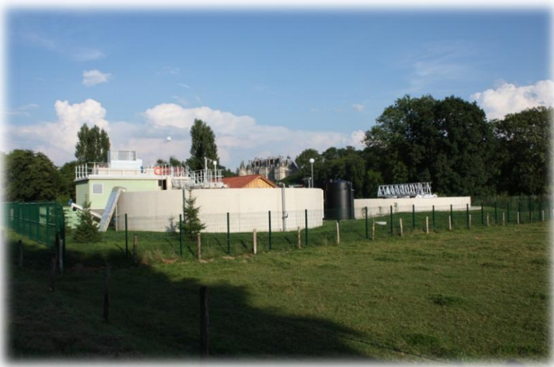
La station d'épuration de Villersexel (70)
